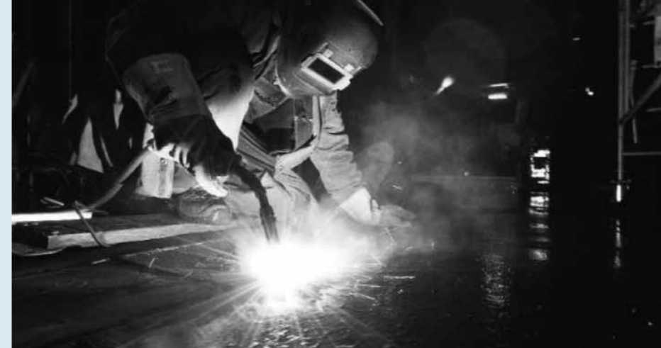
Un employé sur le chantier de Saint-Nazaire en février 2015
